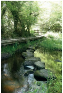
La photo du 9 e magazine a été prise à Brech'h. Il s'agit du platelage de Pont Brech'h (chemin de St-Jacques-de-Compostelle), réalisé par les chantiers d'insertion.
