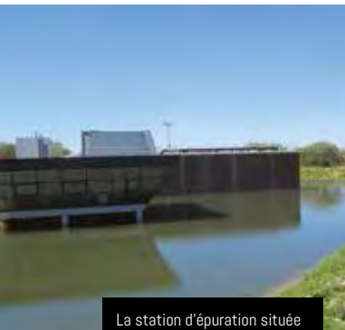
La station d'épuration située à Saint-Philibert.
